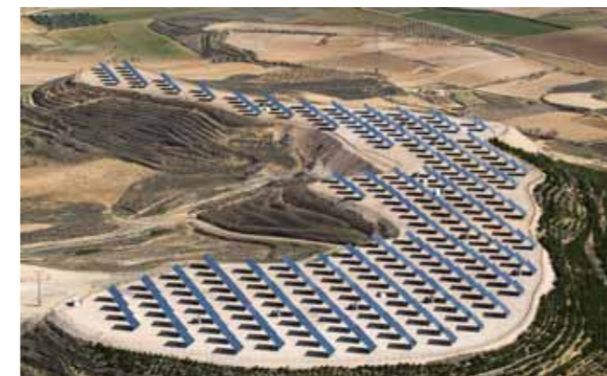
CINTRUENIGO (España). Año 2006. 1,44 MWp. 231 instalaciones.
